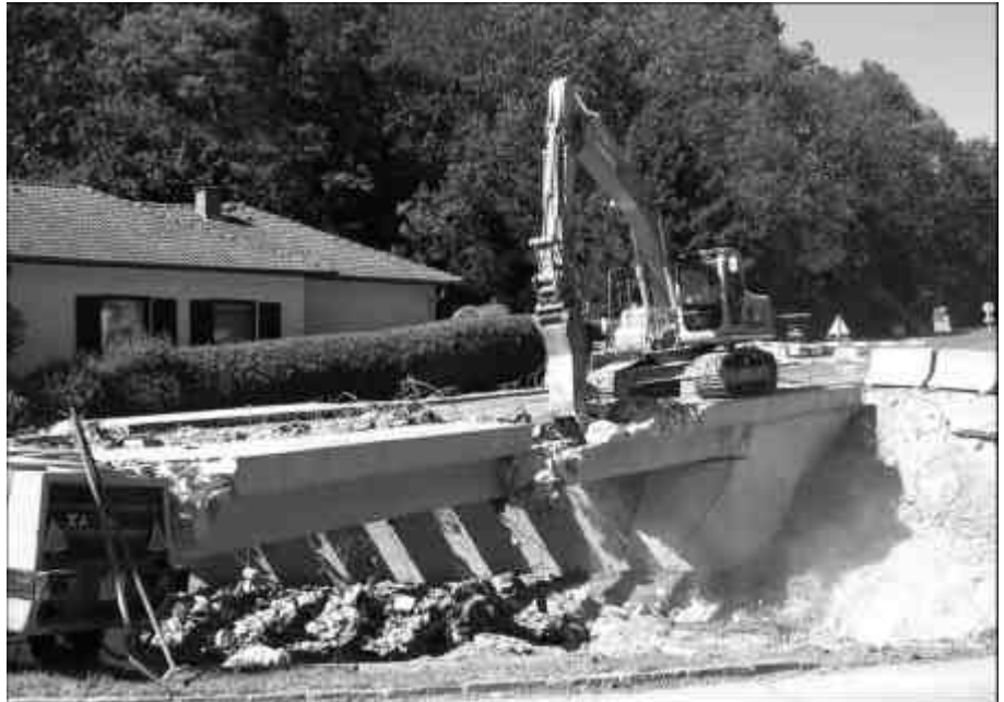
Abbrucharbeiten bei alten Brücke in Altschlaining.
