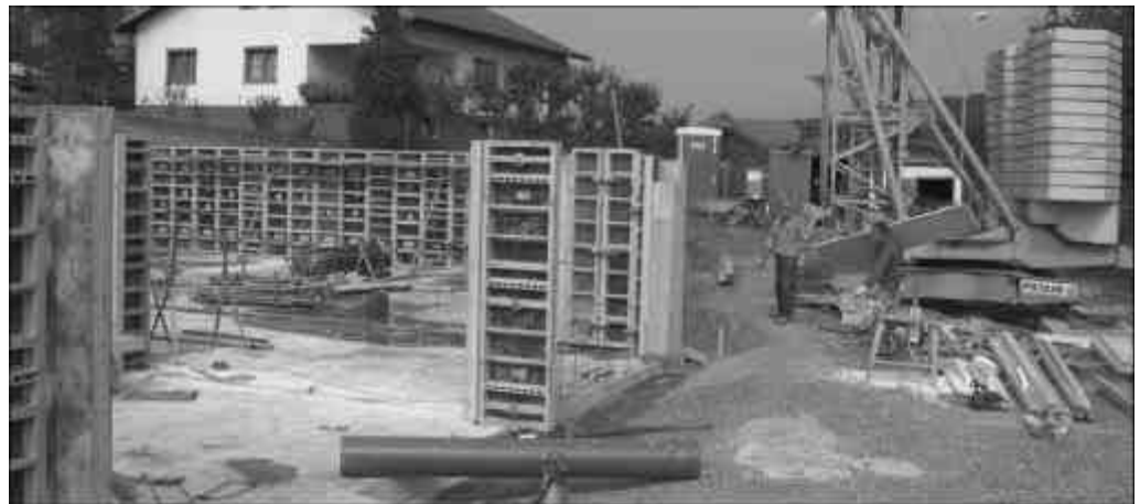
Eifrig wird beim 2. Wohnblock in der Schanzgasse gebaut
